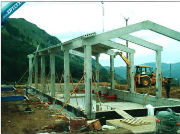
Vista de aplicación de Pilares "R" en Naves.
