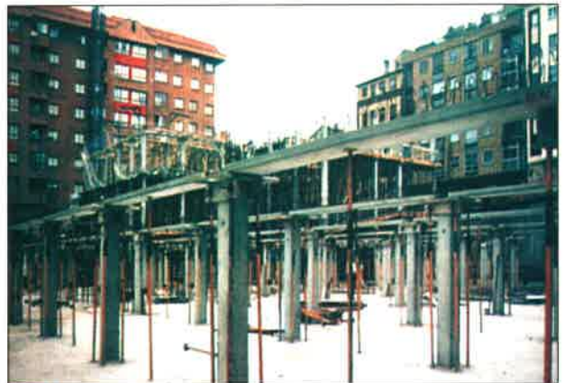
Vista de Pilares "R" en P. Baja.
