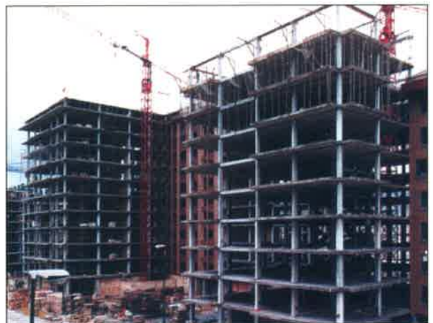
Vista de Pilares "R" en varios Edificios.
