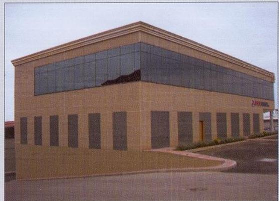
Paneles de fachada horizontales de acabado árido visto color marrón, en combinación con cormisa prefabricada de hormigón coloreado.
