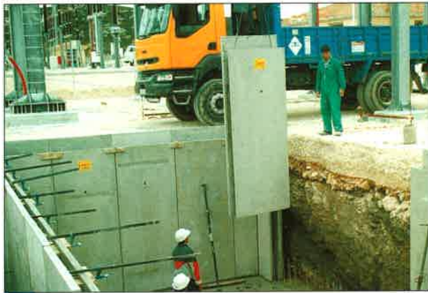
Manipulación muy sencilla de los muros MPR.
