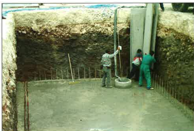
Emplazamiento de cada MPR en la cimentación.
