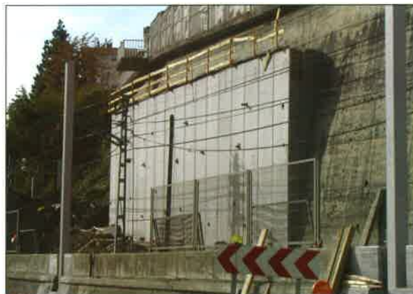
Aplicación del MURO RUBIERA MPR.
