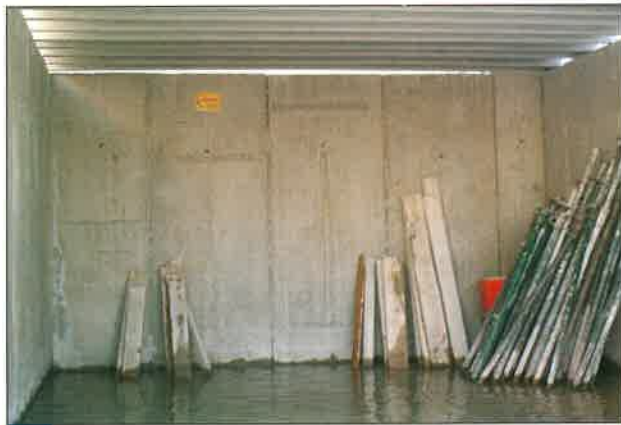
Vista interior del muro MPR.
