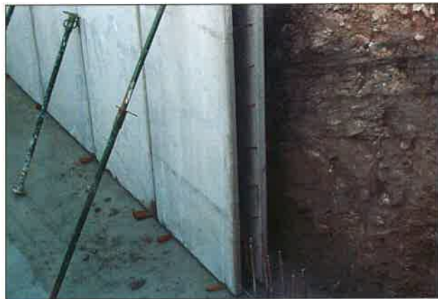
Apuntalado y nivelado del muro MPR.
