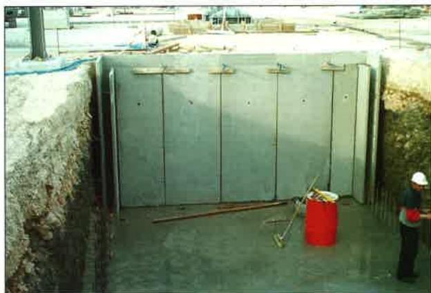
Fase de colocación del muro MPR.
