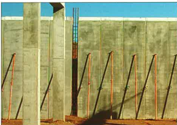
Fase de apuntado del MURO RUBIERA MPR.
