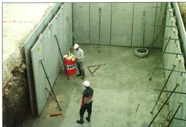
Vista conjunta del muro MPR.
