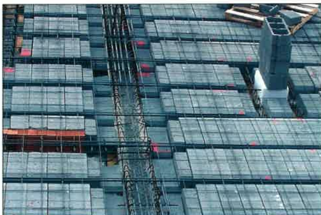
Colocación de Bovedillas
