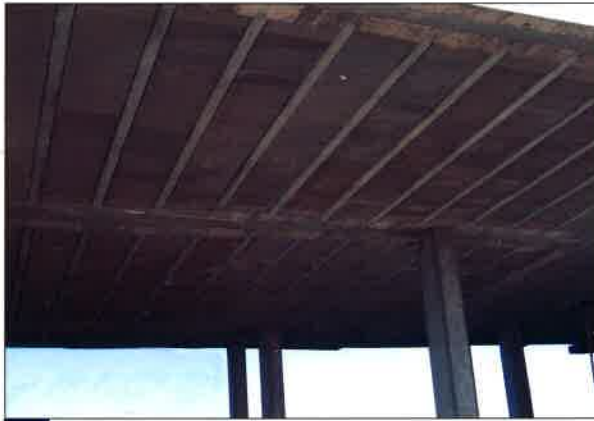
Forjado con Viguetas y Bovedillas de Hormigón
