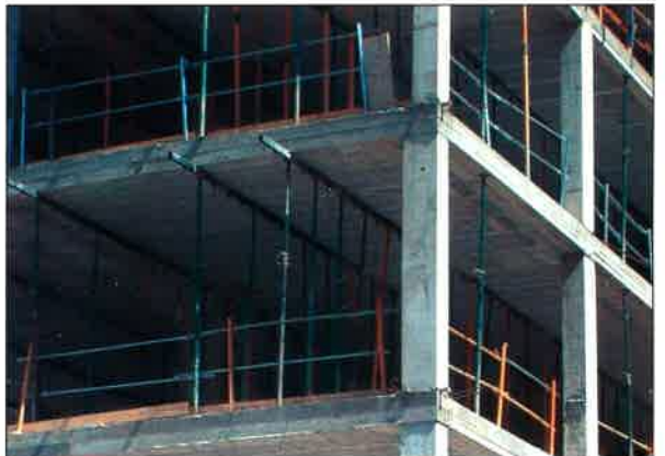
Vista parcial de Edificio con Forjados de Hormigón
