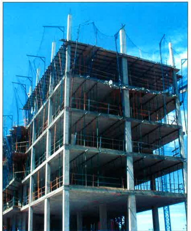
Edificio con Forjados de Bovedilla de Hormigón
