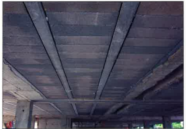
Forjado con Viguetas y Bovedillas de Hormigón
