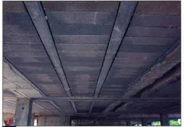
Forjado con Viguetas y Bovedillas de Hormigón
