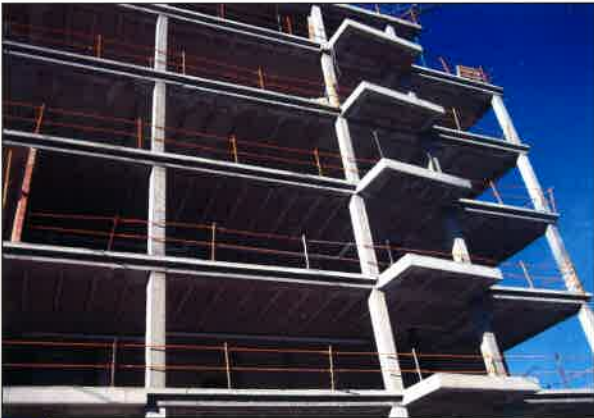
Vista parcial de Edificio con Forjados de Hormigón
