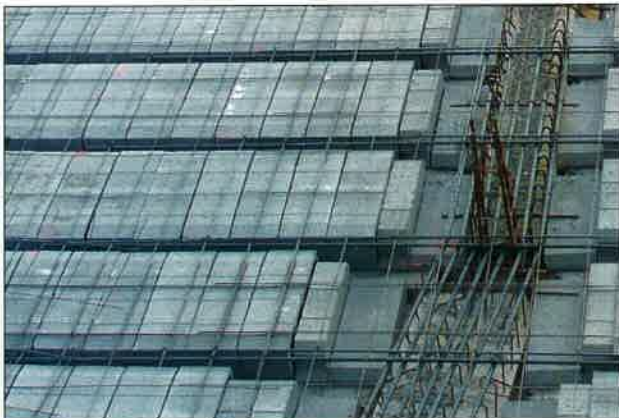
Armadura de Negativos y Repartos
