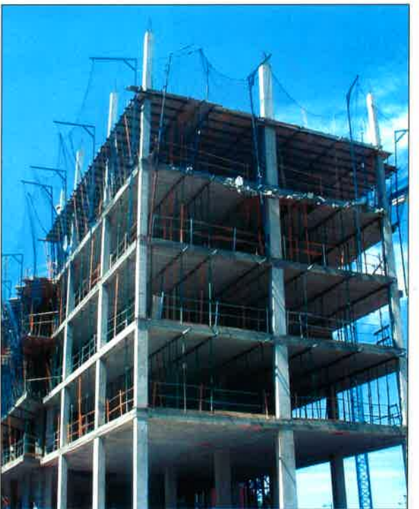
Edificio con Forjados de Bovedilla de Hormigón
