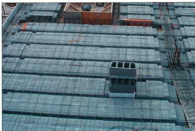
Forjado listo para hormigonar
