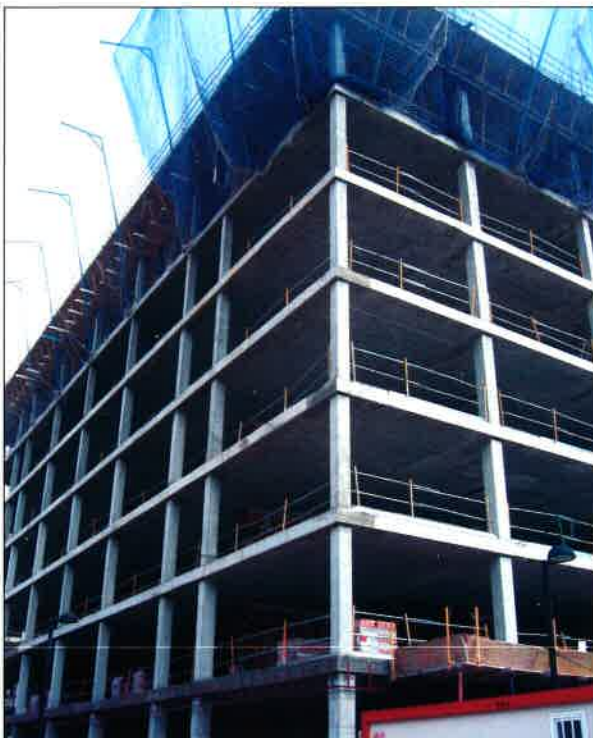
Edificio terminado con Forjados de Hormigón
