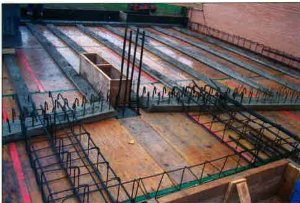
Colocación de Viguetas
