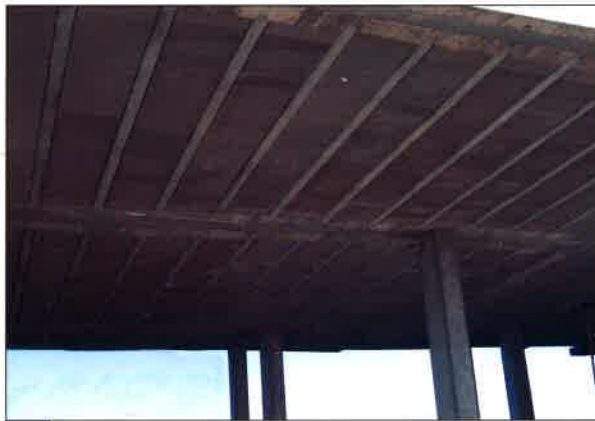
Forjado con Viguetas y Bovedillas de Hormigón
