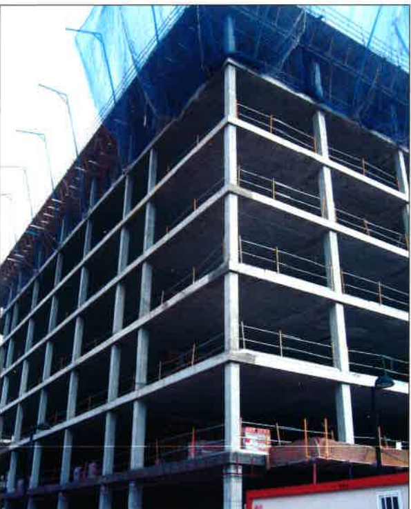
Edificio terminado con Forjados de Hormigón
